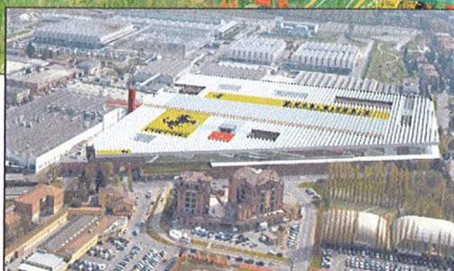
lunghezza (172x56 metri) ortogonalmente a via Enzo Ferrari. Due livelli a quota 0,00 e +12,24 metri occupati interamente dalle linee di montaggio delle vetture a 8 e 12 cilindri. Oltre al corpo di fabbrica principale il progetto include un elemento a ponte che si estende sopra la copertura a shed della parte di fabbrica esistente che non sarà demolita. Questo corpo aggiunto ospiterà il montaggio delle porte e dei cofani e il reparto tappezzeria, e accoglierà anche un nuovo ingresso, garantendo
